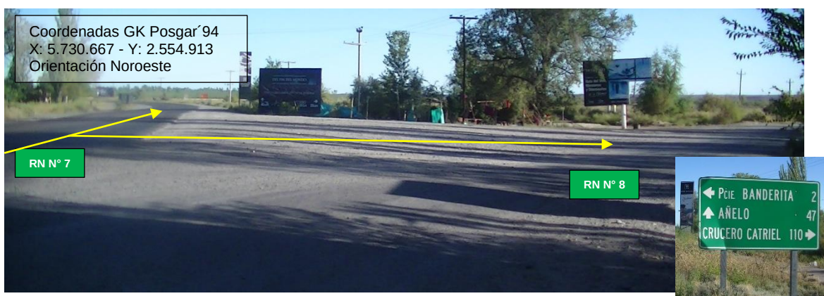
Fotografía N° 1: Intercepción de Ruta Pcial N° 7 y Ruta Pcial N° 8 y detalle de cartel indicador
