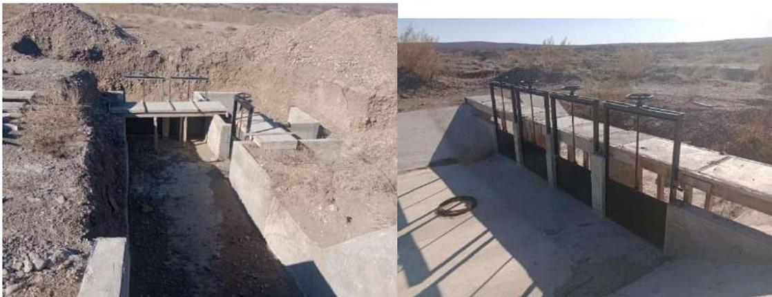
Figura 14 derivación sobre el canal principal hacia el canal secundario
