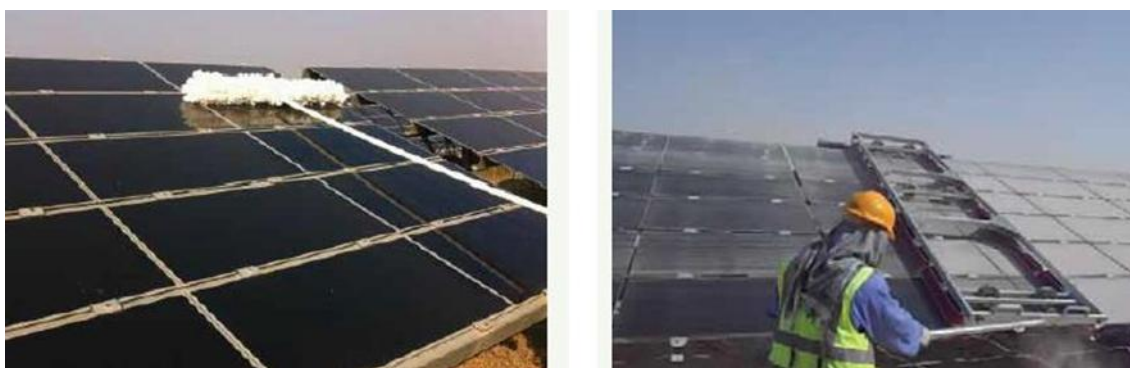
Imagen 14. Limpieza de paneles. Fuente. CAPEX S.A.
