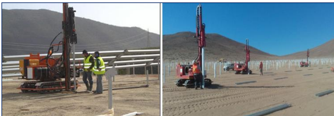
Imagen 11. Ejemplo de tareas de hincado de soportes para seguidores. Fuente. CAPEX S.A.
