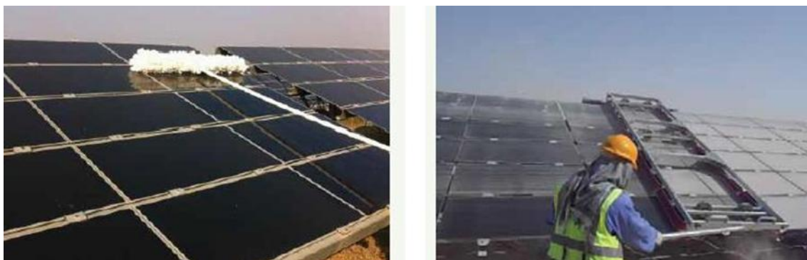
Imagen 16. Limpieza de paneles. Fuente. CAPEX S.A.
