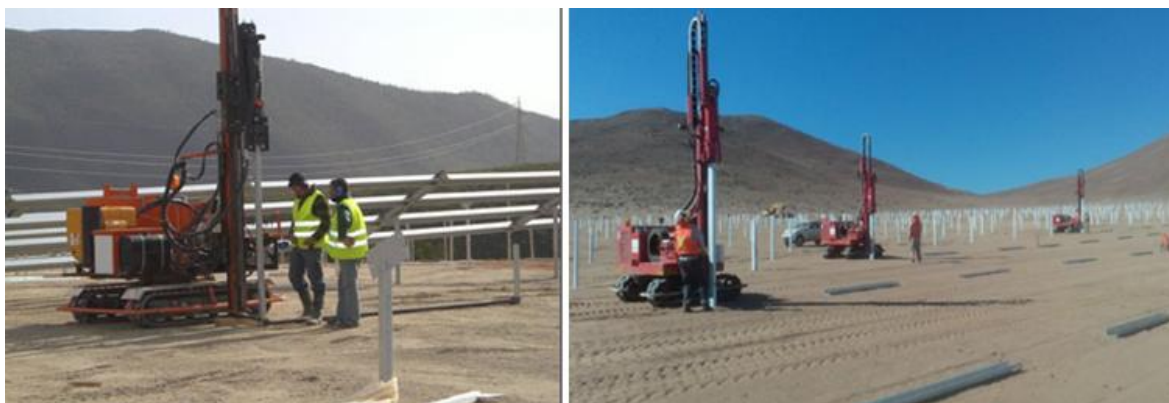
Imagen 13. Ejemplo de tareas de hincado de soportes para seguidores. Fuente. CAPEX S.A.
