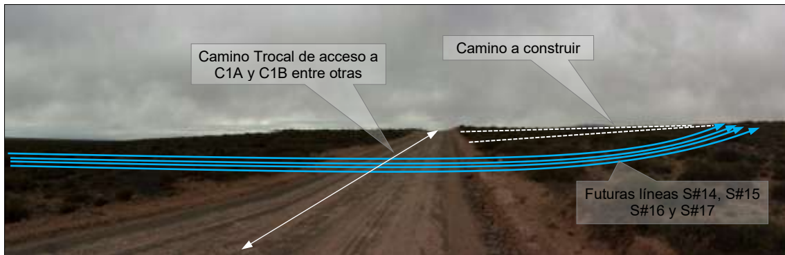
Foto N° 106: Vista en dirección Este. Se observa el cruce de las trazas de las futuras líneas S#14, S#15, S#16 y S#17 del camino Troncal del BIN C, para luego continuar al Sureste paralelas a camino a construir. Coordenadas x: 5833305; y: 2486670.
