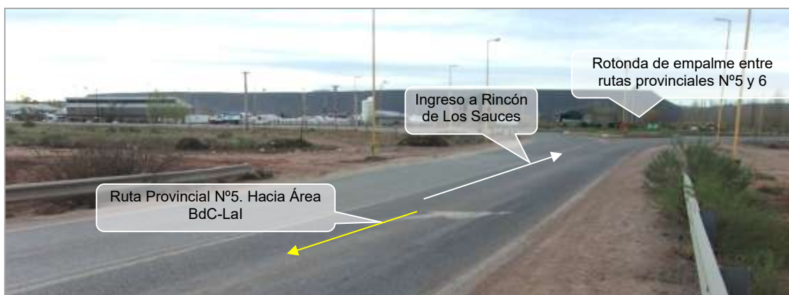
Foto N°1: Vista al Norte del empalme entre las Rutas Provinciales N° 5 y 6, en el ingreso a la localidad de Rincón de Los Sauces, en la Provincia del Neuquén. Coordenadas: x: 5.861.086; y: 2.508.276.
