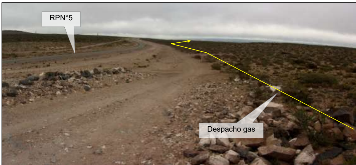
Foto N°72: Vista panorámica en dirección Suroeste. Se observa la Ruta Provincial N° 5 y pista de ductos existente que será aprovechada por el ducto troncal de Despacho gas (amarillo). Al fondo, se señala el sector en el cual el ducto cambiará de rumbo aprovechando una línea sísmica. Coordenadas x: 5829155; y: 2489406.
