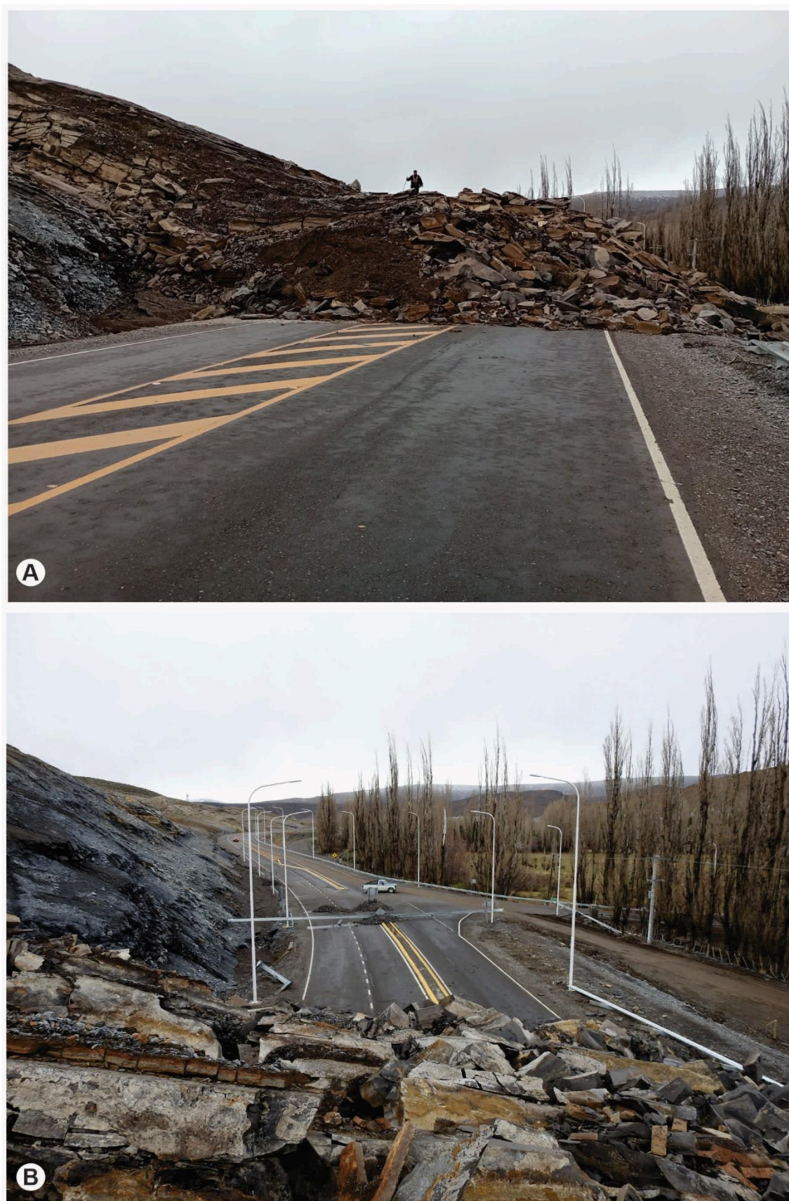
Figura 5. Acúmulo frontal del deslizamiento del día 01/08/2023.
