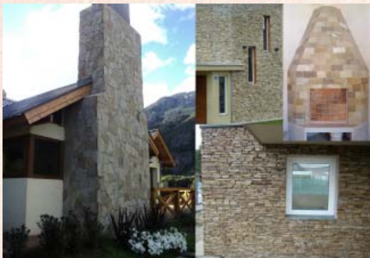
Colocación del material como revestimientos
