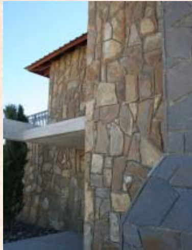
Detalle colocación en frente de vivienda
