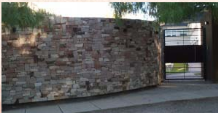
Revestimiento de muro
