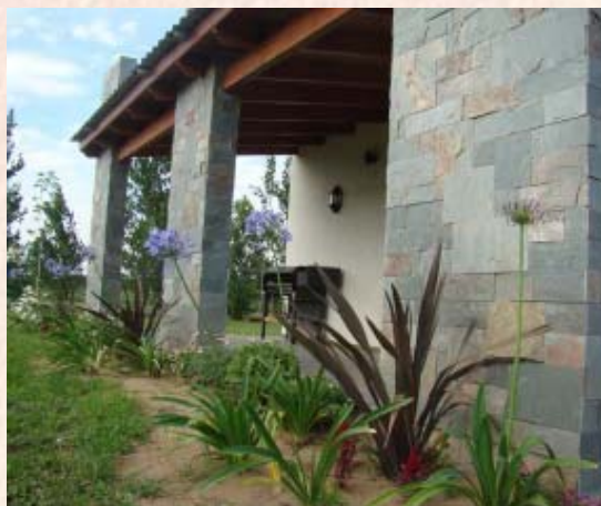
Revestimiento de muros en vivienda unifamiliar
