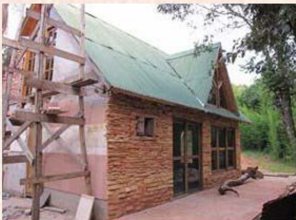
Colocación de la piedra laja
