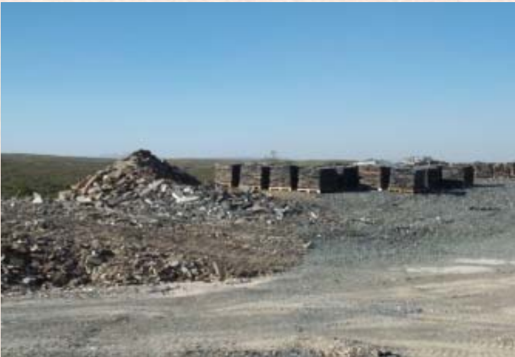
Acopio de lajas
