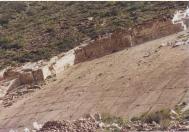
Detalle de labores sobre el faldeo
