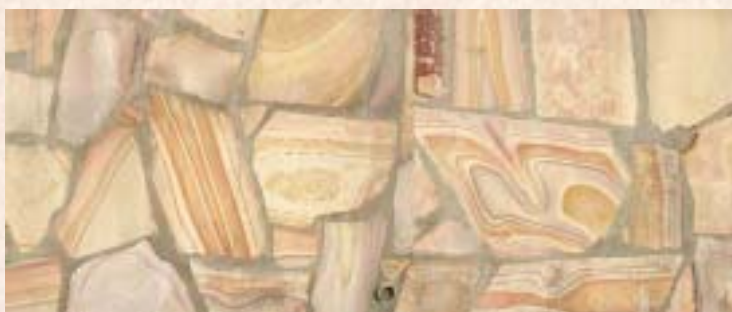
Detalle del muro revestido
