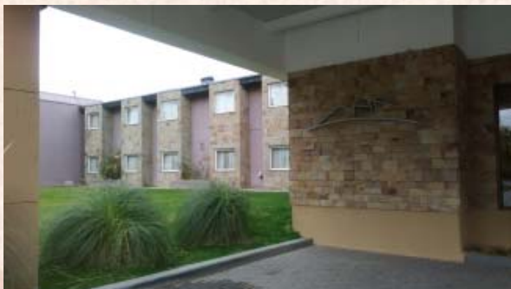
Paredes externas del Hotel Malargüe Inn & Suites
