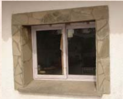
Revestimiento del perímetro de una ventana
