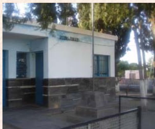
Colocación en fachada de vivienda
