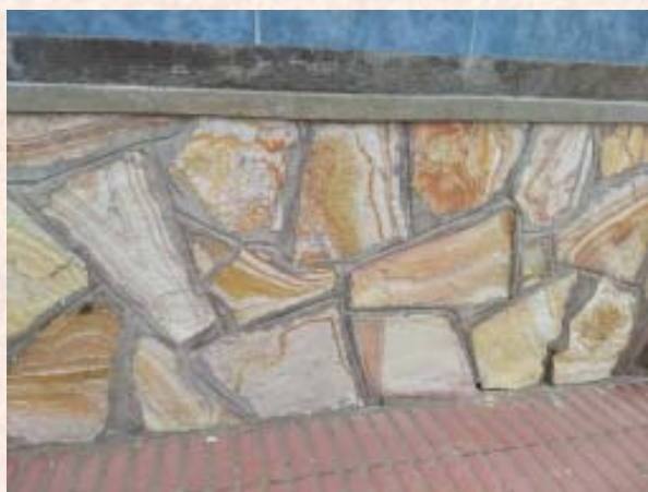
Revestimiento de fachada
