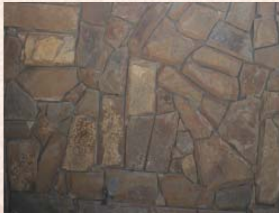
Colocación en frente de vivienda
