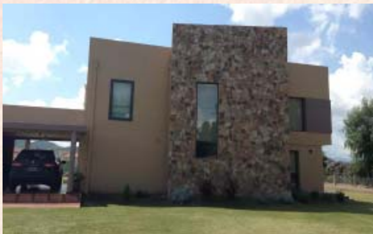
Muro en vivienda unifamiliar
