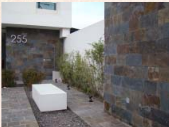
Lajas cortadas y colocadas como revestimiento
