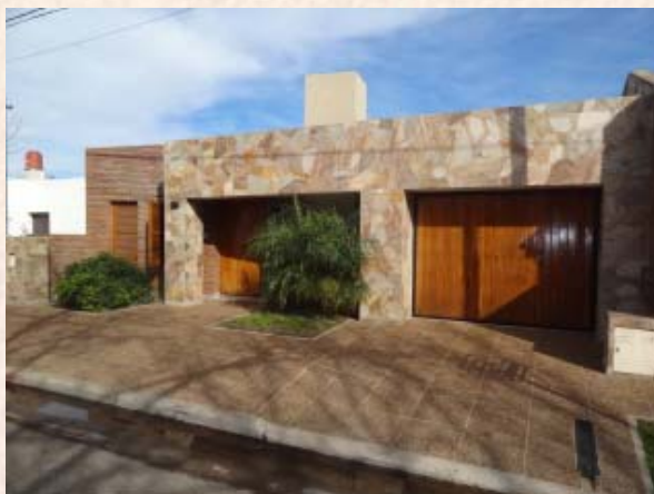
Revestimiento de fachada en vivienda unifamiliar
