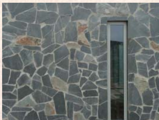
Revestimiento de fachada
