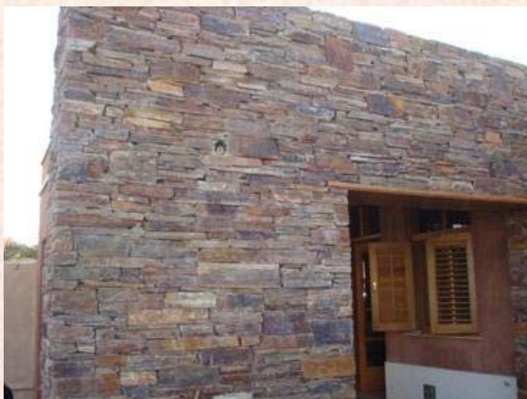
Muretes en paredes
