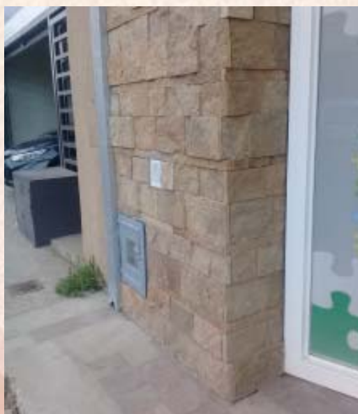
Revestimiento de fachadas
