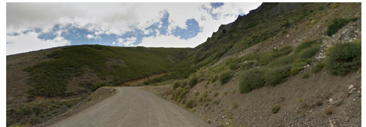
▲ Imagen 13. Ruta Provincial N° 46. Fuente: Google Street View, 2023.
