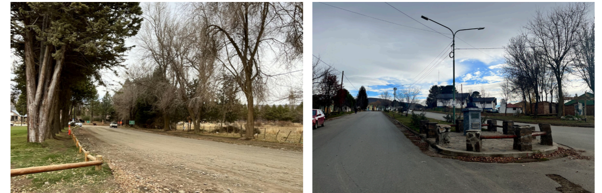
▲ Imagen 14. Izquierda: calle sin pavimentar. Derecha: Av. R.I.M 26, pavimentada. Ninguna vía cuenta con infraestructura peatonal adecuada.
