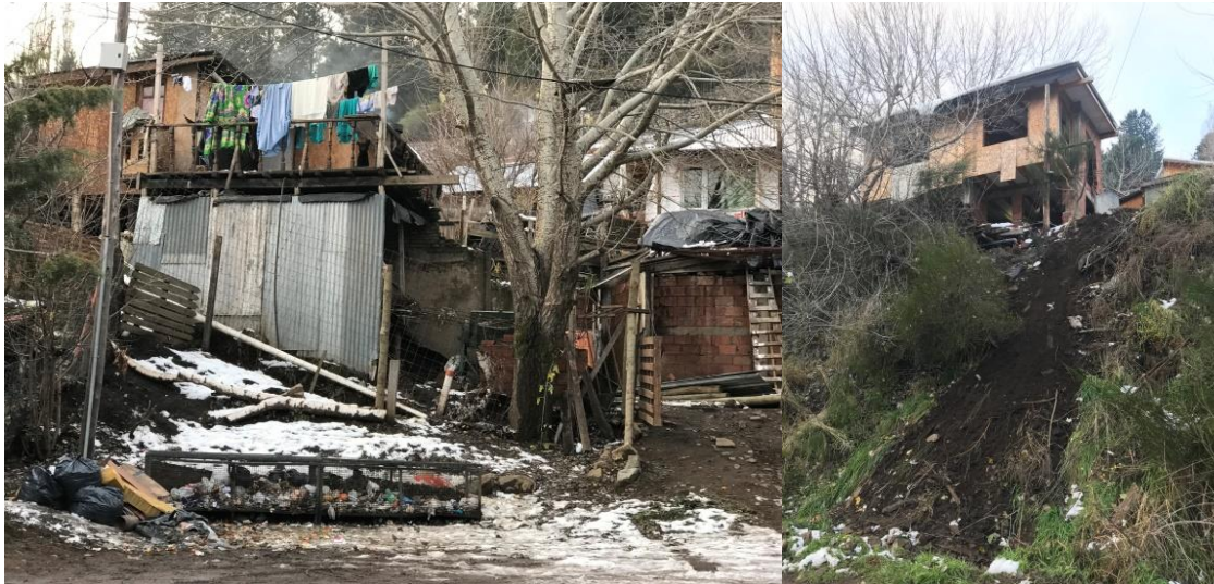
Figura 20. Barrio Colonia Maipú, se aprecia el riesgo geofísico, especialmente en la imagen de la derecha.
