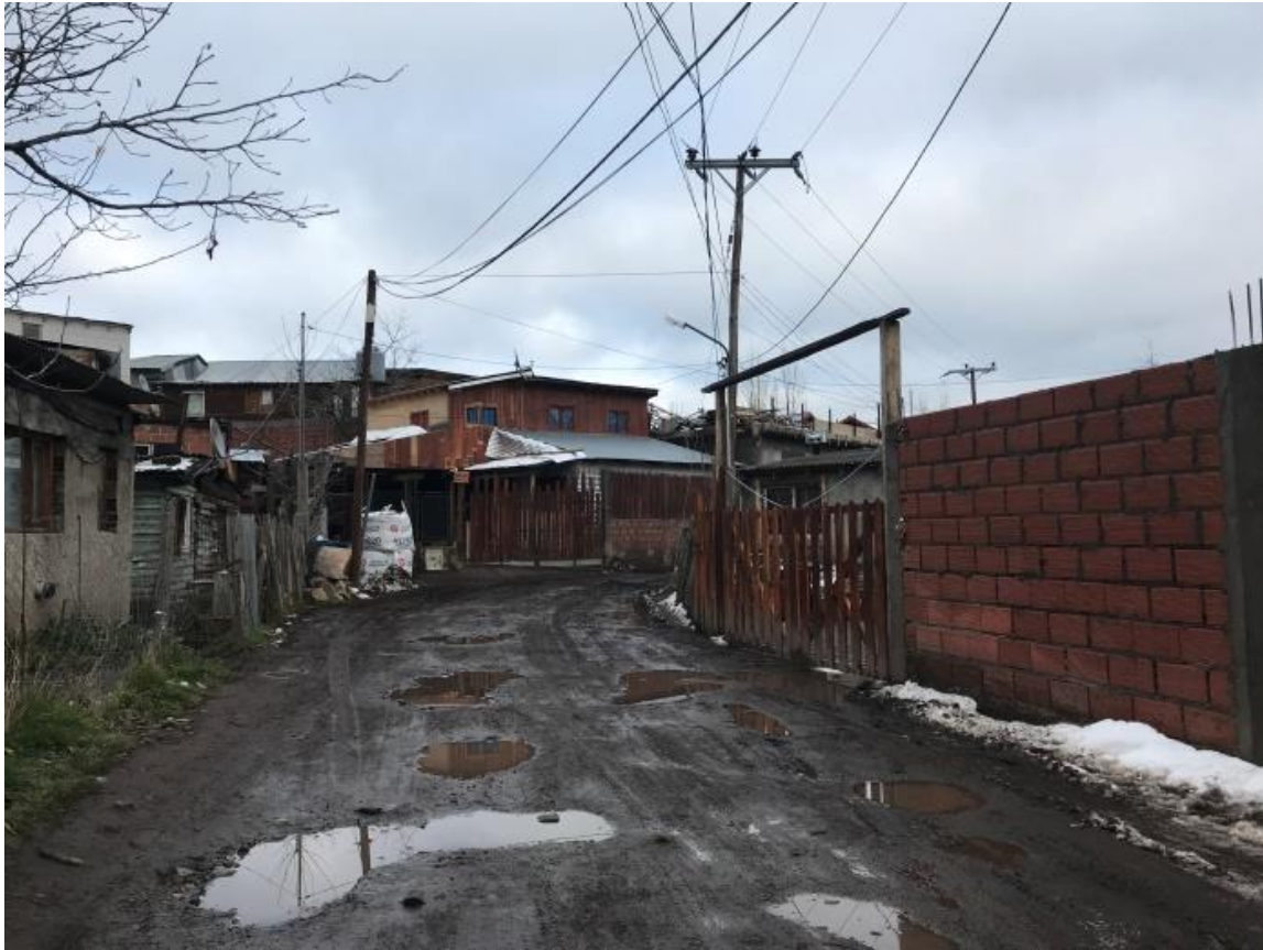
Figura 19. Barrio La Isla, se aprecia la facilidad de estancamiento de agua en las calles.
