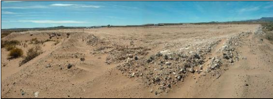
Foto N° 64: Vista panorámica al Nor-Noreste en la se observa la locación B5B, en construcción al momento del relevamiento, ubicada en el área de influencia directa del proyecto, aproximadamente a 50 m al Norte del predio de vinculación proyectado. Coordenadas x: 5826123; y: 2488279.
