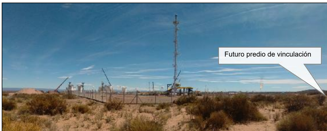
Foto N° 59: Vista panorámica al Noroeste en la que se observa el flare de la EPF/TPF BdC, ubicada en el área de influencia directa del proyecto. Coordenadas x: 5825741; y: 2488355.
