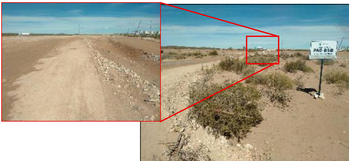
Fotos N°61 y 62: Vista al Sur desde el camino troncal de yacimiento BdC, en la que se observa el camino de acceso a la locación B5B. El tramo final del oleoducto proyectado se emplazará paralelo al lateral Oeste del camino. Coordenadas: x: 5826453; y: 2488266.
