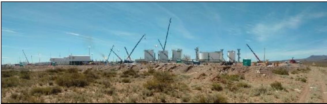
Foto N° 58: Vista panorámica hacia el Este-Noreste en la que se observa las instalaciones de la EPF/TPF BdC, ubicada a aproximadamente 60 m del sitio de desarrollo de las obras. Coordenadas x: 5825685; y: 2487846.
