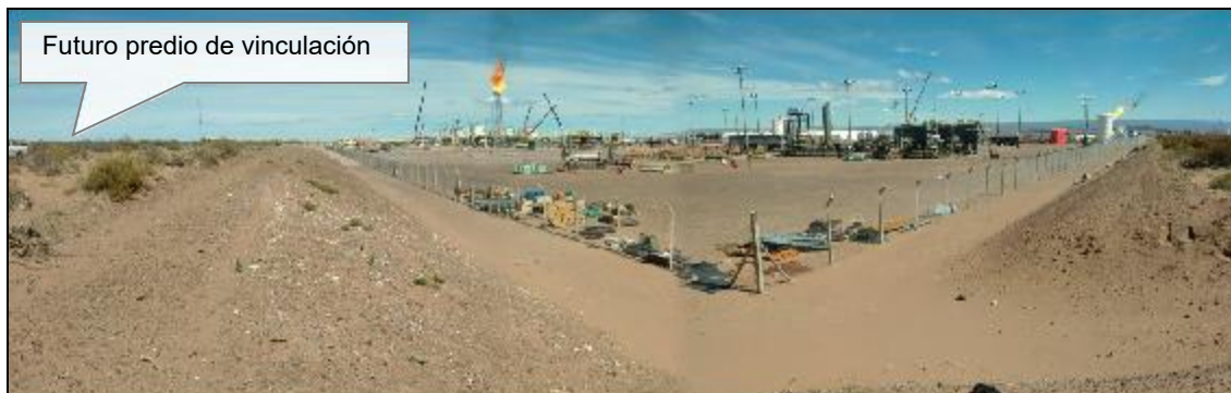
Foto N° 60: Vista panorámica al Suroeste en la que se observa el predio y las instalaciones de la EPF/TPF BdC, ubicada en el área de influencia directa del proyecto, aproximadamente a 200 m al Suroeste del predio de vinculación proyectado. Coordenadas x: 5826291; y: 2488198.
