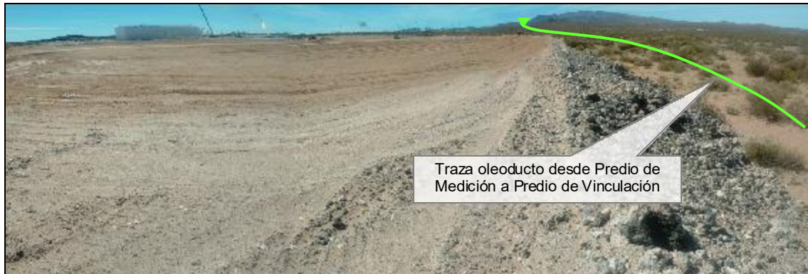
Foto N° 57: Vista en dirección Este desde el límite Sur del predio de la base operativa (donde se realizan tareas de ampliación), en la que se representa la traza del oleoducto proyectado ubicada entre 30 m y 50 m aproximadamente al Sur del predio. Coordenadas x: 5825614; y: 2487110.
