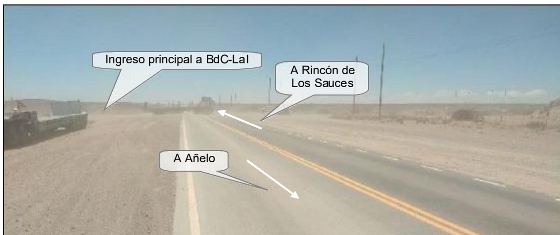
Foto N°3: Vista hacia el Noroeste, sobre la Ruta Provincial N° 5, se observa el ingreso al área en estudio BdC-LaI. Coordenadas: x: 5.826.431; y: 2.488.682.
