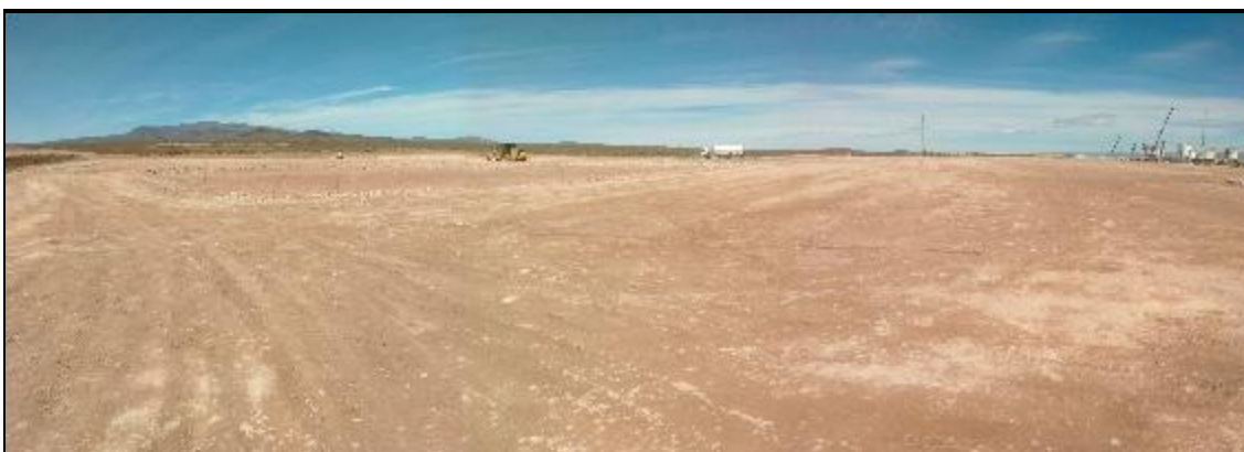
Foto N° 63: Vista panorámica al Sur suroeste en la que se observa la locación B5B, en construcción al momento del relevamiento del proyecto, ubicada en el área de influencia directa del proyecto. Coordenadas x: 5826258 y: 2488299.
