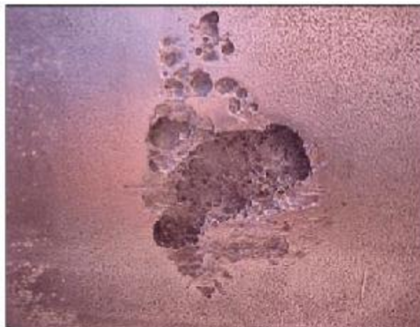
Figura 3. Defecto de pérdida de metal asociado a Corrosión Externa
